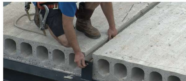
Figuur 49. Montage kanaalplaatvloer
