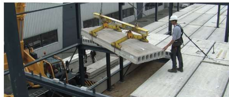
Figuur 49. Montage kanaalplaatvloer
